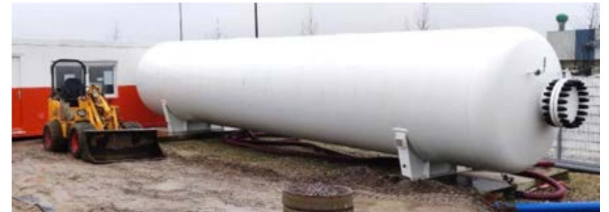
Voorbeeld van 40bar waterstof opslagtank voor ca. 100kg waterstof. (foto HyMatters)
