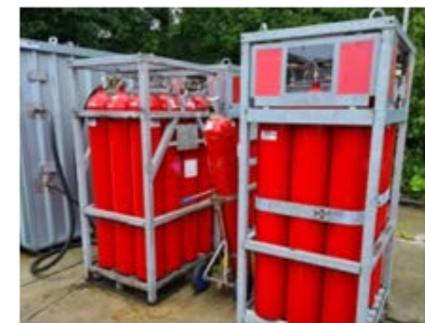
Voorbeeld van waterstof opgeslagen in 200 bar en 300 bar cilinders met een opslagcapaciteit van circa 1 kg waterstof per cilinder.
